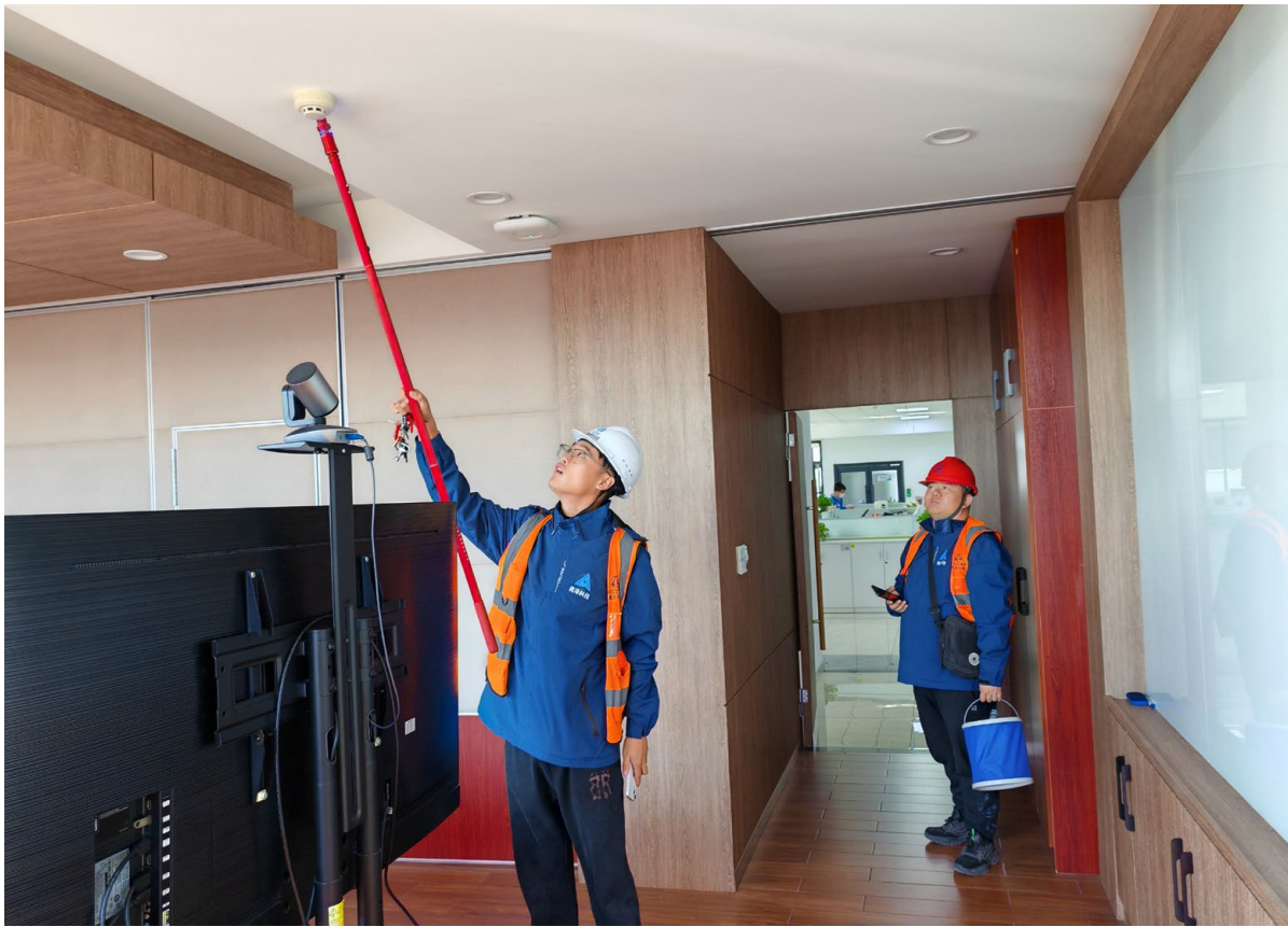
消防维保单位对烟感探测器进行检查
