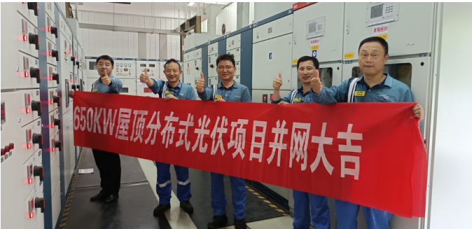
650kW 屋顶分布式光伏项目并网
